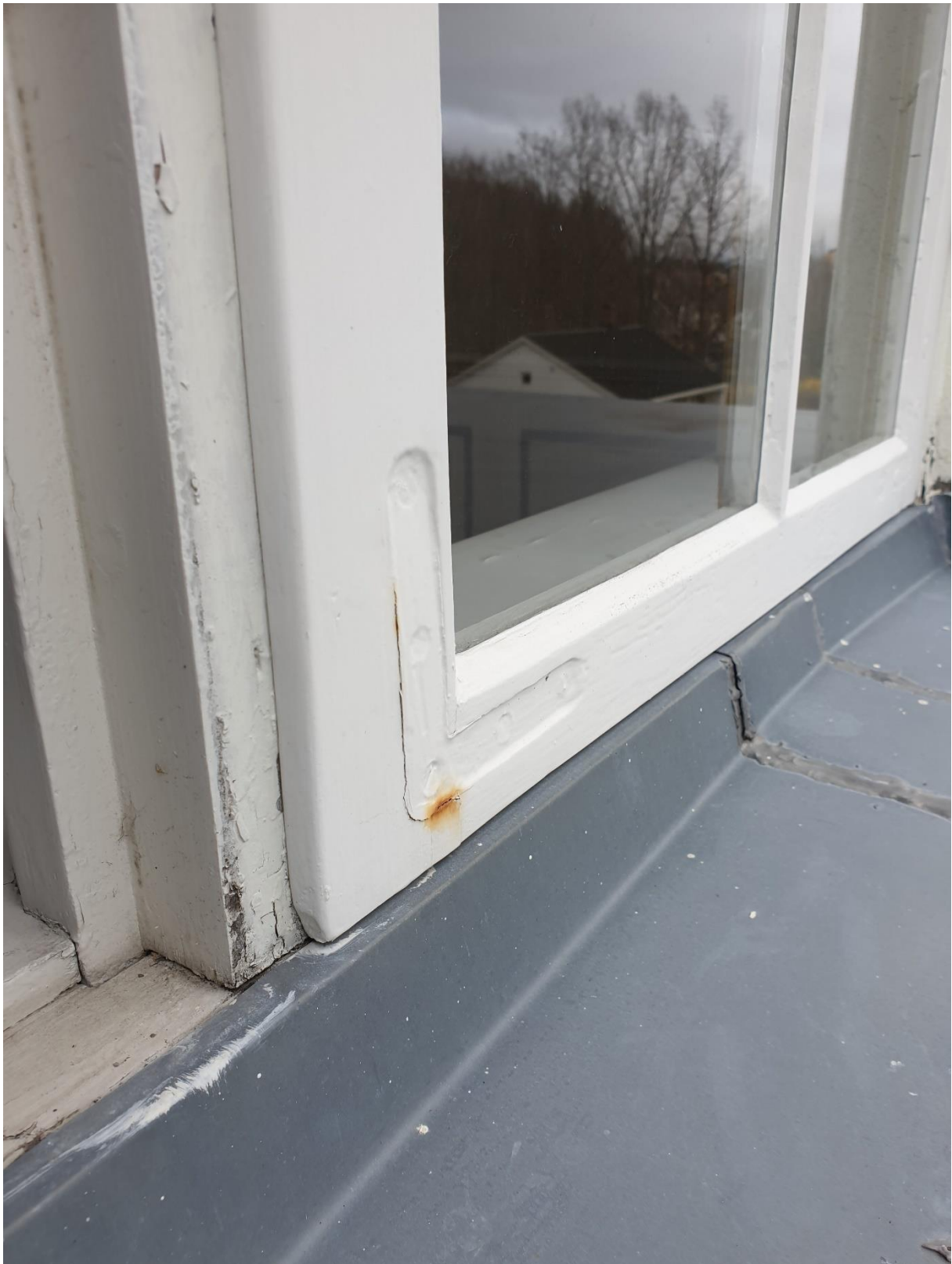
Nord, over skilderhus nordvestre hjørne, rust på beslag og sårbar løsning med takteking
